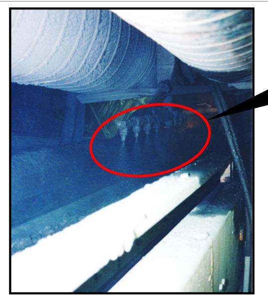
Bedüsen des Ausbruchmaterials mit Wasser
